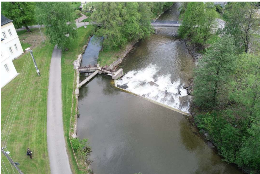
Jez Brantice, dnešní stav
