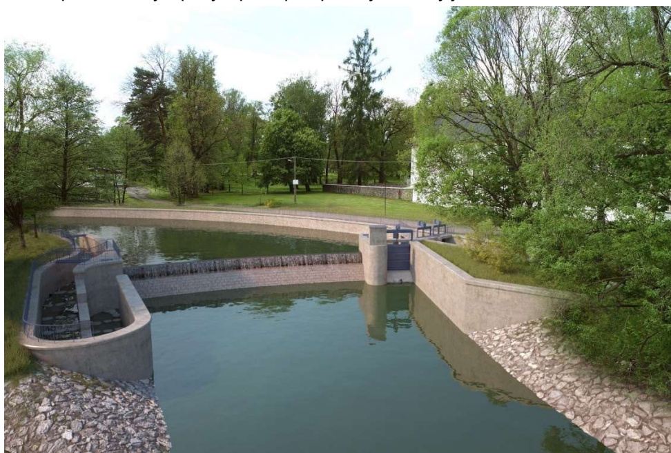
Pohled proti proudu (z mostu) řeky Opavy na nový jez a okolí
