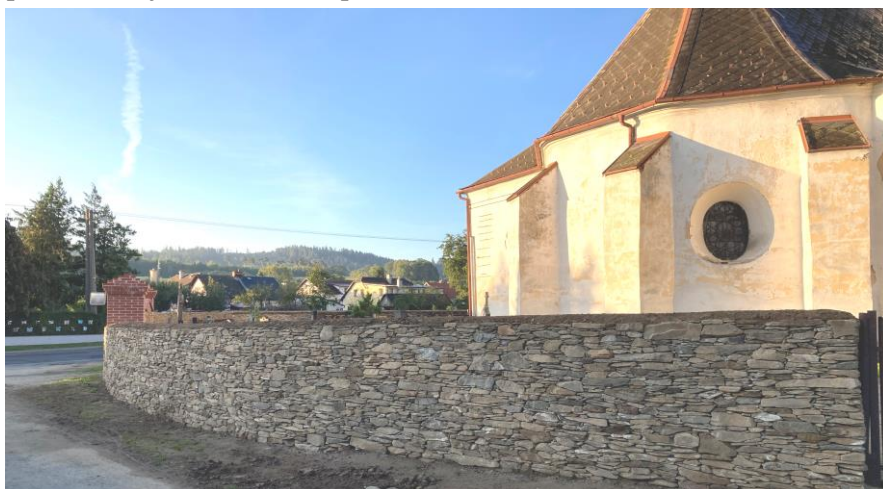
V září byla dokončena oprava zdi okolo hřbitova v Branticích.
